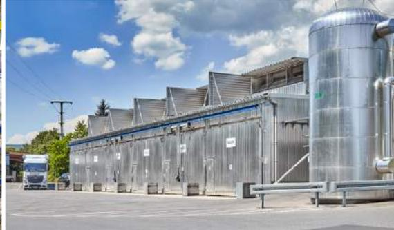
Die Trockenkammern werden mit der Abwärme eines BHKWs beheizt.
